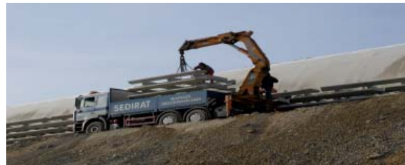
Raumgitterwand: Verlegung beim Semmeringtunnel
