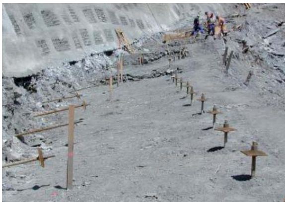
Sicherung der Fundamentplatte durch Pfähle GEWI 50 und schräge Anker IBO 38
