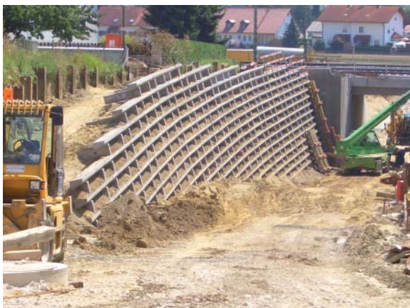
Bild 6: Raumgitterwand, Kreisstraße El 9 Gaimersheim/BRD, Bauzustand. Foto: Walter Herzog
