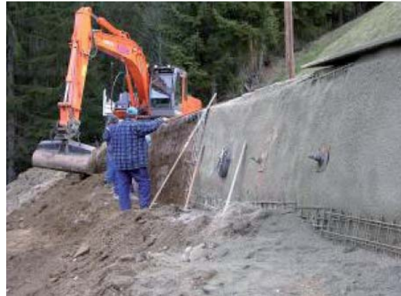
Offener Abtrag auf ca. 1,5 m Tiefe, Baugrubensicherung
