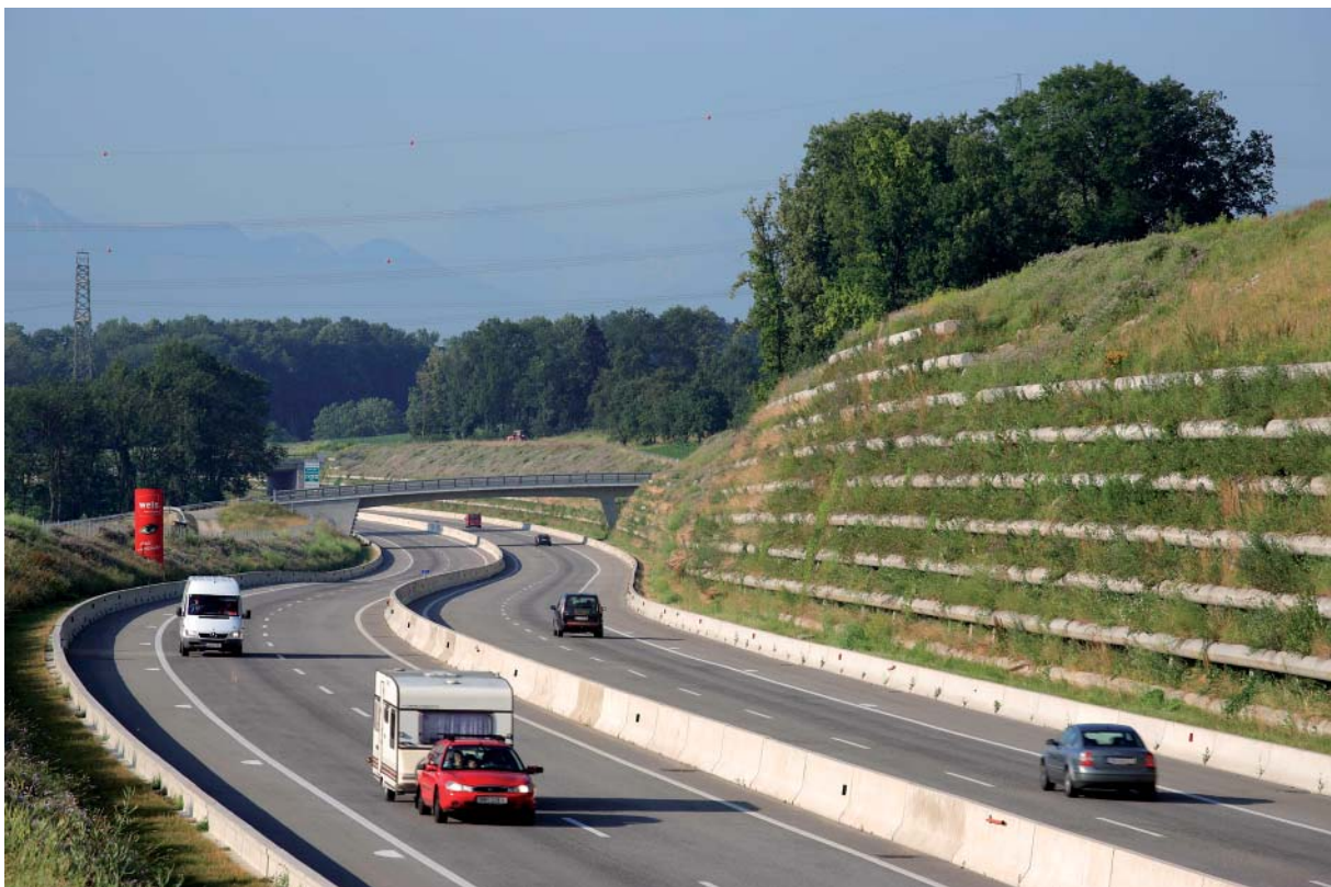
Bild 1: Stützkonstruktion „Welscher Verbau“, A8 Westtangente Wels. Foto: Darren Penrose
