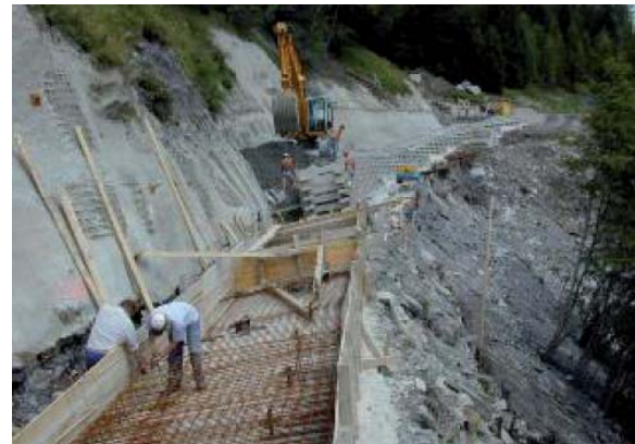
Voreilende Fundamenterstellung und beginnender Aufbau der Krainerwand
