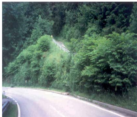
Raumgitterwand: Arriacher Landesstraße
