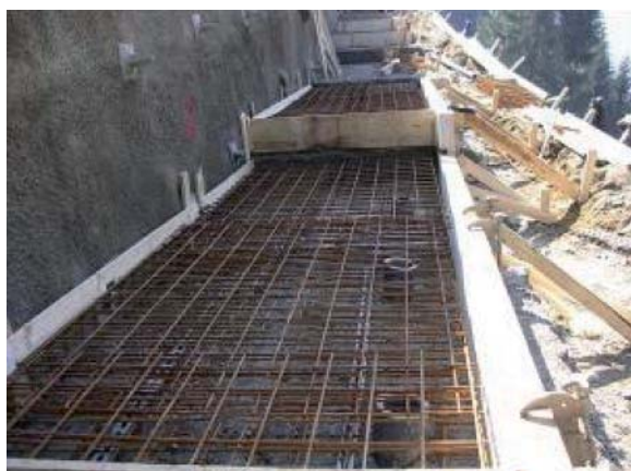
Einbinden der Pfahlköpfe in die Fundamentbewehrung
