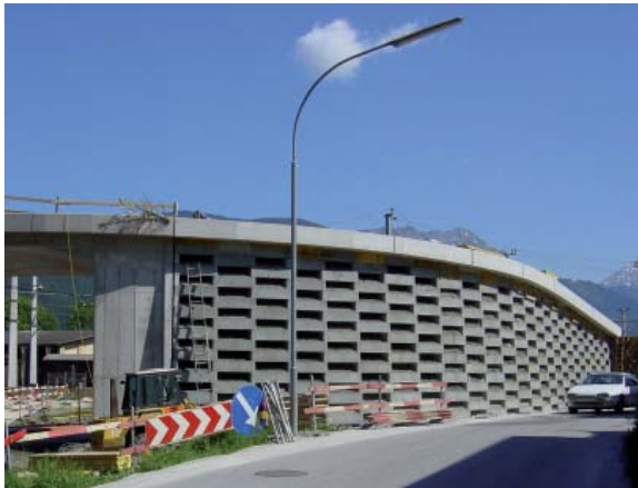
Bild 17: „Rampe Selzthal“, NEW-Junior-Stützwand nach Fertigstellung. Foto: GTB Anif
