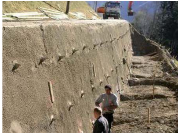
Weiterer Abtrag bis auf Sohlentiefe, 2. Stufe Baugrubensicherung
