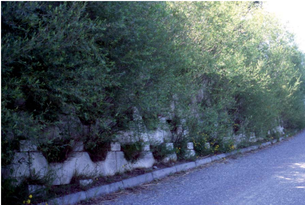
Abb. 2: Mit Weidensteckhölzern bepflanzte Betonkrienerwand
