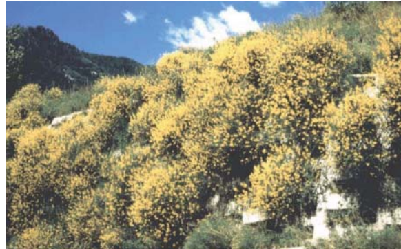
Bild 12: NEW-Wand in Norditalien
