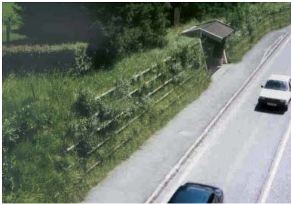
Raumgitterwand: Umfahrung Zell am See
