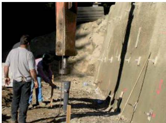
Rammen von duktilen Pfählen in der Baugrubensohle
