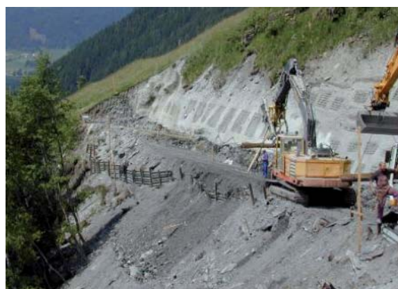
Abtrag und Baugrubensicherung
