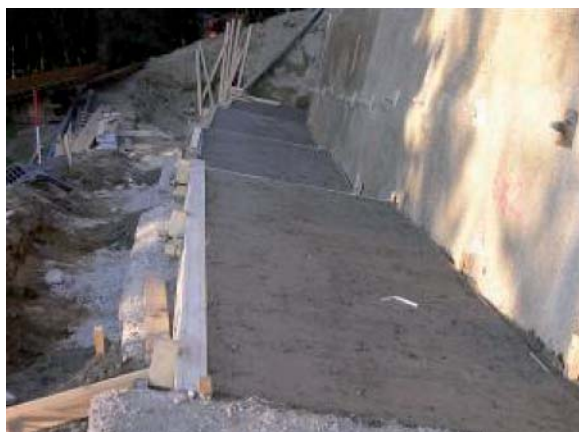
Betonieren der Fundamentabschnitte (Länge jeweils 5 m)
