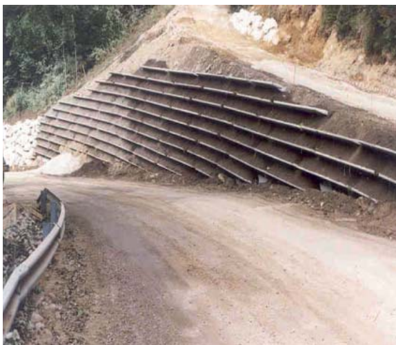
Raumgitterwand: Arriacher Landesstraße
