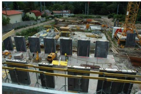
Fertigteile mit ISO-Körben
