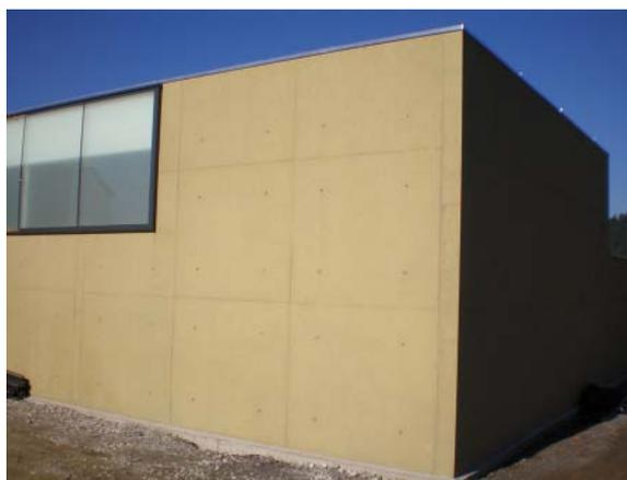
Abbildung 3: Sandgestrahlter Farbbeton mit besonders harmonischer Oberfläche
