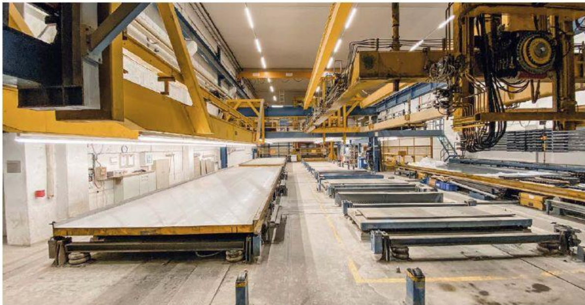
Vollautomatisierte Indoor-Fertigung von Betonfertigteilen auf Palettenumlaufanlagen.
