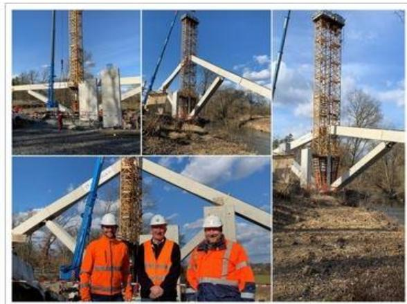
Die neue Brückenbautechnik spart nicht nur Zeit, sondern auch Geld, und die Haltbarkeit der Brücke ist gleich oder sogar besser als bei anderen Brückentechnologien, wie Kollegger betont. Besonders vorteilhaft ist die Klapp-Methode, wenn man schwieriges Gelände überbrücken möchte, in das man nicht stark eingreifen möchte – etwa in einem Naturschutzgebiet, wie im Fall der nun gebauten Lafnitz-Brücke.
