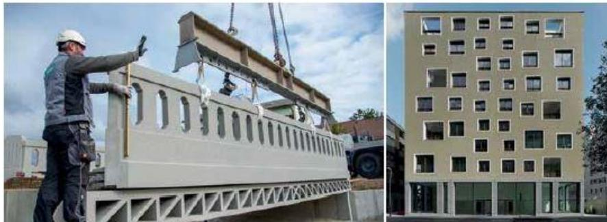
Der Nachbau einer historischen Brücke in Siebenhirten und der Wohnpark PaN in Wien zeigen, dass man industriell gefertigte Betonfertigteile auch handwerklich bearbeiten kann.
