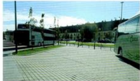
Hydroaktive Pflastersteine aus Beton kommen beim Arrival Center Schönbrunn zum Einsatz
