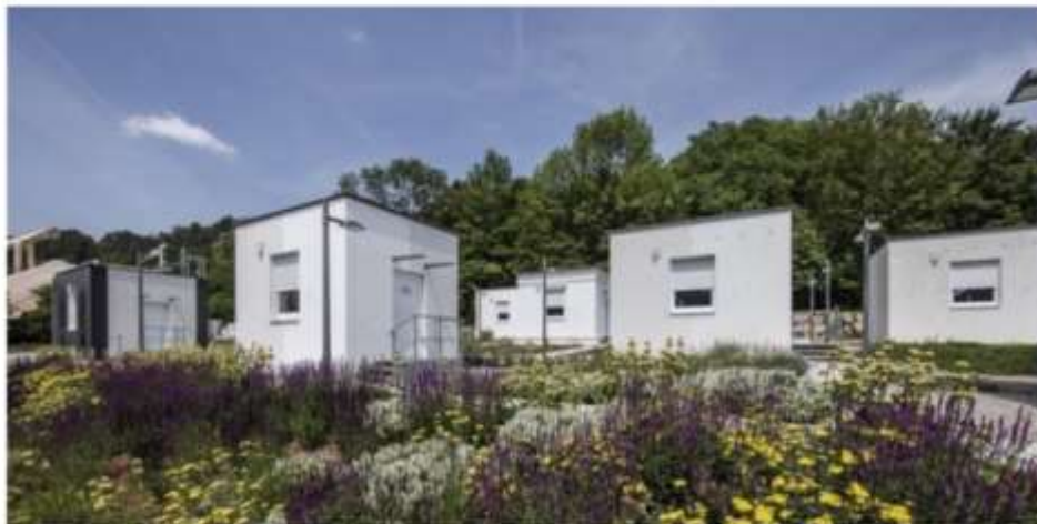
Die kleinen Häuser im Baumit-Forschungspark sind unterschiedlich gedämmt und hitzen sich im Inneren bei hohen Außentemperaturen demnach auch unterschiedlich stark auf. Foto: Baumit
