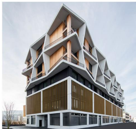
Bild: »Beton steht nicht nur für protzige dicke Träger, sondern kann durch technische Optimierung dünne, schlanke Baukonstruktionen bilden«, verweist Reinhold Lindner auf die schlanken Strukturen durch vorfabrizierte Glasfaserbetonelemente am Suurstoffi-Areal in der Schweiz.
