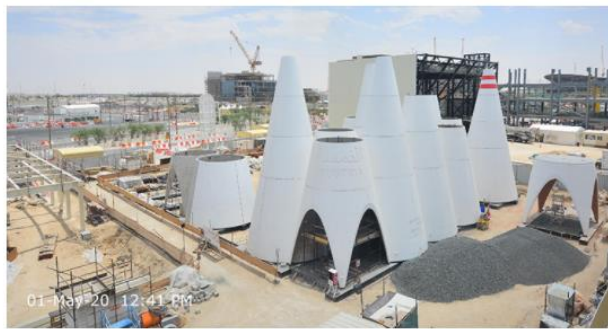
Expo2020 - Austria-Pavillon © Martin Nüssli, querkraft architekten
