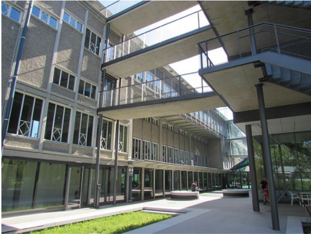
Bild: Alte Massivstrukturen in neue Projekte einzubeziehen spart Energie, Ressourcen und Kosten. Ein Ergebnis intelligenter Planung ist die revitalisierte Krieau, Wiens ältestes Stahlbetongebäude.
