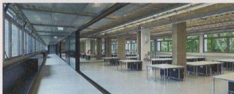
Schwanner-Trakt am Oskar-Kokaschka-Platz – die Betonfertigteile konnten erhalten werden. Ein Vorteil des Baukastensystems des denkmalgeschützten Baus ist die Flexibilität in den Räumen
