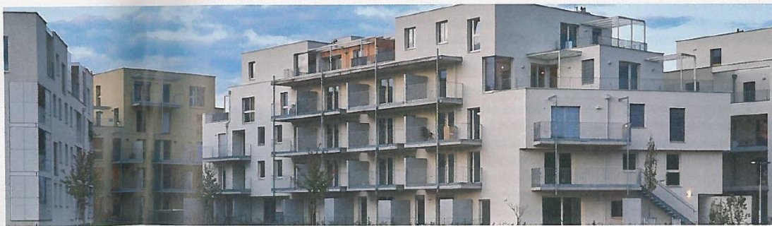
Thermisch aktivierte Geschossdecken und Überschussstrom sorgen für besonders geringe Energiekosten
