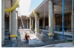
In den bauteilaktivierten Betondecken sind rund 40 Kilometer Rohrleitungen zum Heizen im Winter und zum Kühlen im Sommer verlegt.
