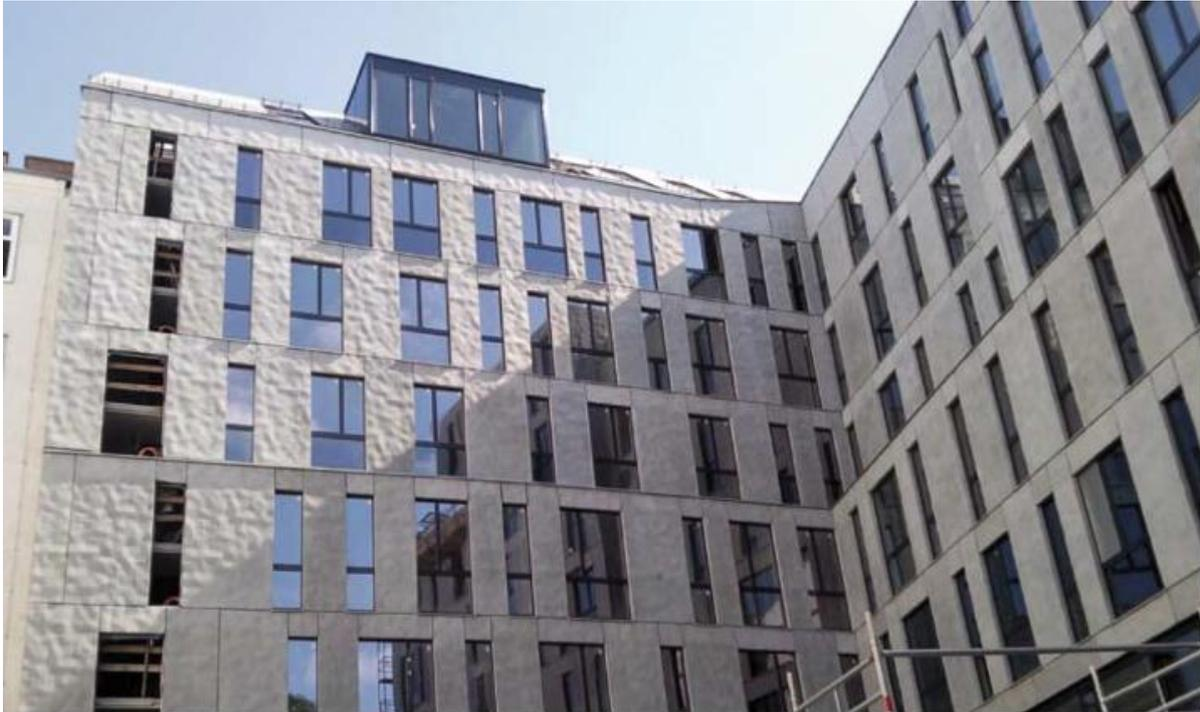
Die Betonfassade eines neuen Institutsgebäudes der Universität Wien in der Währingerstraße wird derzeit mit einer speziellen Oberflächenstruktur mithilfe von Matrizen hergestellt.
