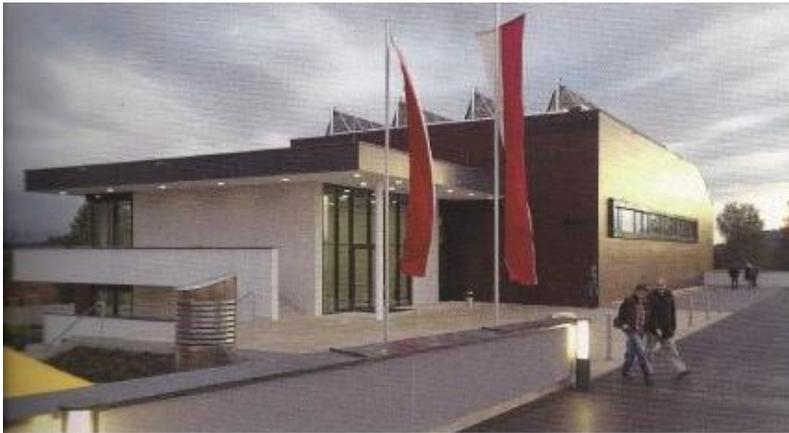
Um die Photovoltaikanlage mit einer Leistung von 18,6 kWp möglichst unsichtbar zu halten, wurde sie sehr flach auf das Dach des Haupteingangs montiert. Ihre Daten werden auf einem Display im Foyer angezeigt.
