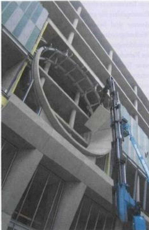
Ovale Fassadenverkleidung. Die markanten Bullaugen des neuen Bahnhofs „Wien Mitte“ bestehen aus vorgefertigten Betonelementen.
