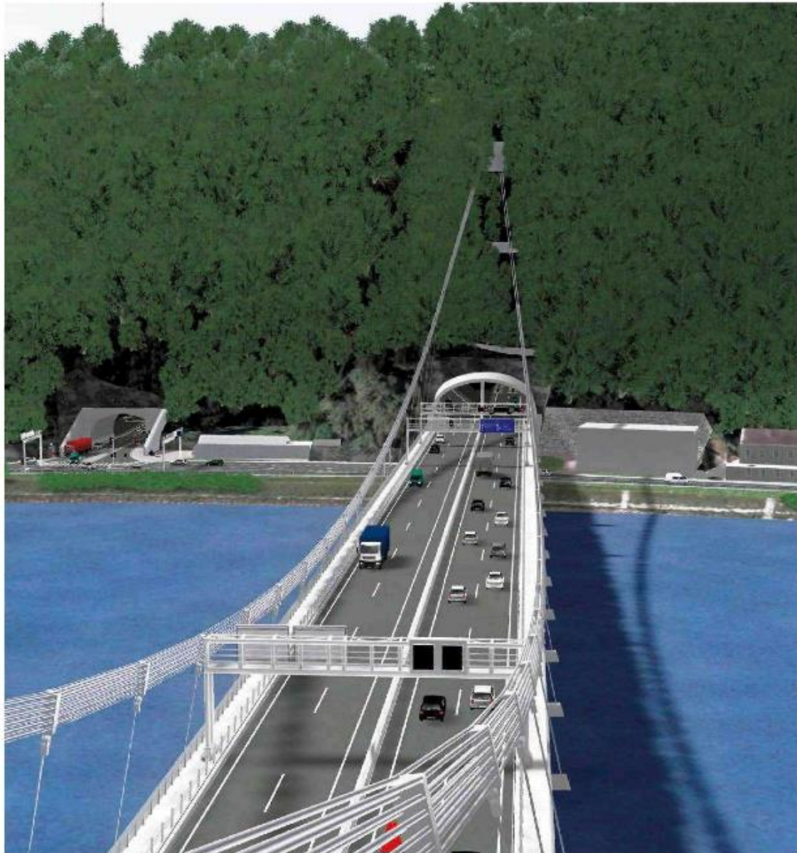
A 26, Linzer Autobahn mit Donaubrücke. Baustart war 2015, Freigabe 2019. Kosten: 546 Millionen Euro.
