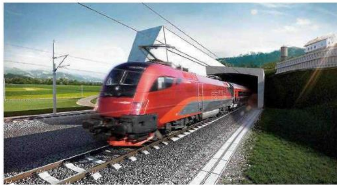
Koralmbahn mit Koralmtunnel: Ausbau der Südbahnstrecke mit Semmering-Basistunnel und Hauptbahnhof Graz.
