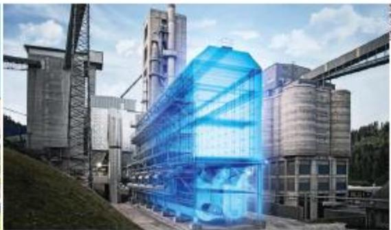
Das Kirchdorfer Zementwerk punktiert sich nur durch seine außergewöhnliche Optik. Rechts die innovative DeCONOX-Anlage, die den CO<sub>2</sub>-Ausstoß verringert und die Abwärme nutzbar macht
