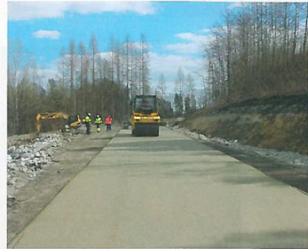
**FORSCHUNG.** Innovativer Walzbeton auf 500 Metern Teststrecke in der Südsteiermark. Belastbar, bleibt frei von Spurrillen, verformt sich nicht in der Sommerhitze.
