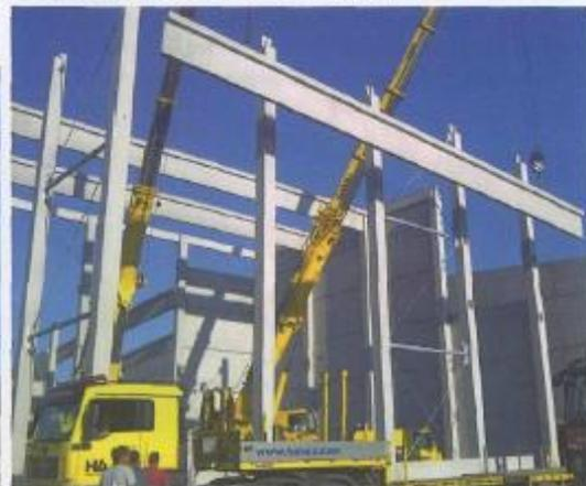
Skelettbauweise. Die neue Maschinenhalle der steirischen Zellstoff Pöls AG zeichnet sich dank der Stahlbeton-Fertigteile durch höchste Stabilität aus.
