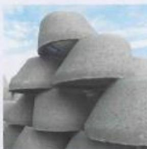
Ovale Fassadenverkleidung. Die markanten Bullaugen des neuen Bahnhofs „Wien Mitte“ bestehen aus vorgefertigten Betonelementen.
