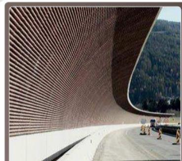
Effektiv gegen Lärm: Schutzkonstruktionen aus Beton.
