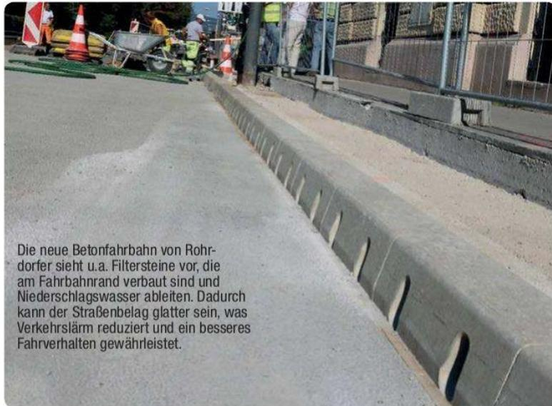
Die neue Betonfahrbahn von Rohrdorfer sieht u.a. Filtersteine vor, die am Fahrbahnrand verbaut sind und Niederschlagswasser ableiten. Dadurch kann der Straßenbelag glatter sein, was Verkehrslärm reduziert und ein besseres Fahrverhalten gewährleistet.
