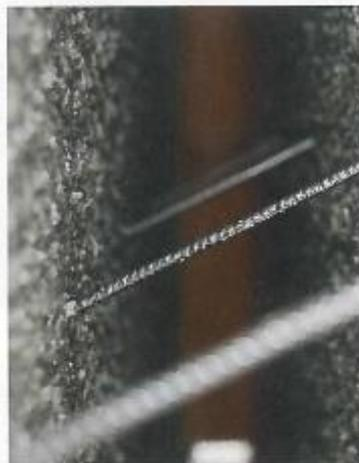
Bei der Korbwand von Maba werden zwei dünne Betonwände vorproduziert und mit Stäben aus Bewehrungsstahl, die vollautomatisch angebracht werden, verbunden.
