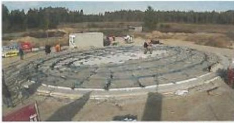
Die meisten Betonschalen müssen mit komplexen und kostenintensiven Holzkonstruktionen gestützt werden. Die vom Institut für Tragkonstruktionen der TU Wien entwickelte Baumethode »Pneumatic Forming of Hardened Concrete« setzt bei einem Testbauwerk der ÖBB-Infrastruktur in Kärnten auf Luftkissen und Spannkabel.
