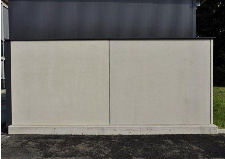
Optisch kein Unterschied: links ein Öko²-Beton-Element, rechts ein Element aus Standardbeton.
