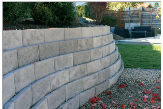
Bild 4: Geschwungene und versetzte Böschungssteinwand
