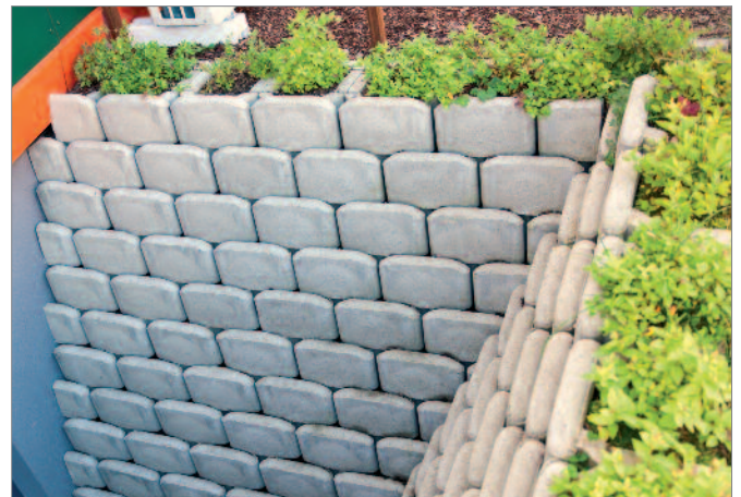
Bild 8: Versetzte Wand mit beplanzter Mauerkrone
