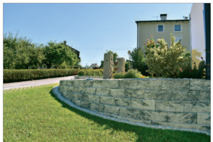
Bild 5: Geschwungene und versetzte Böschungsmauer
