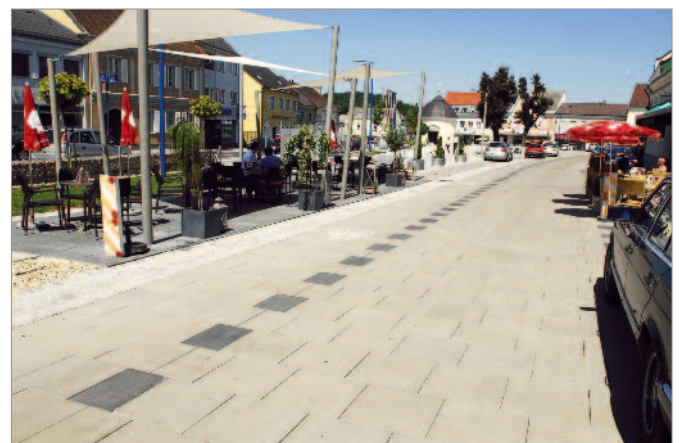
Bild 2: Nur bei einer regelgerechten Fugenbreite können Betonsteine bei Aufgrabungen aus der Fläche genommen und wieder verlegt werden.
