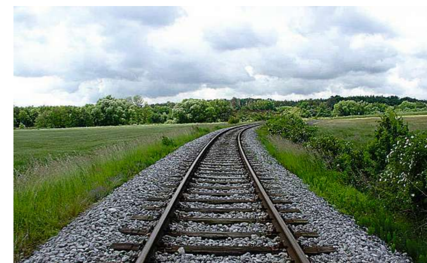
Bahnschotter ist wesentlich für die Erhaltung der österreichischen Infrastruktur
