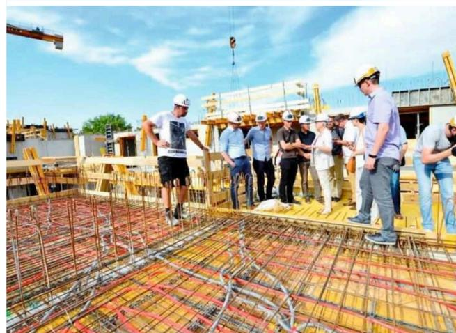
In der Mühlgundgasse wird erstmals die thermische Bauteilaktivierung zum Heizen und Kühlen mit Windenergie im städtischen, sozialen Wohnbau eingesetzt
