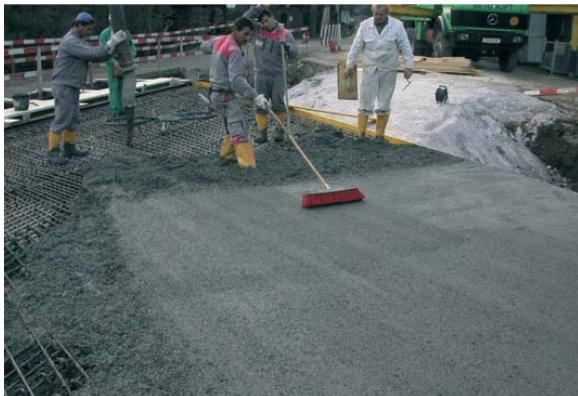
Abb. 4: Herstellen des Aufbetons
