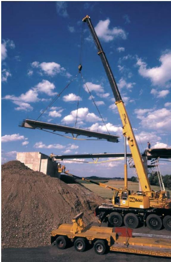
massiven Fertigteilen. Aus Gewichtsgründen wurden schließlich hohle Fertigteile entwickelt, die schon die komplette Bewehrung enthielten. Die 18 m langen und 20 t schweren „Äste“ wurden mit zwei Autokränen auf die „Stämme“ versetzt. Zunächst wurden die Fertigteile im oberen Viertelpunkt durch Rüsttürme unterstützt und gegenseitig abgespannt. Das Ausbetonieren der Hohlräume vervollständigte die „Äste“. Die Rüsttürme dienten später auch der Herstellung des Tragwerks.
