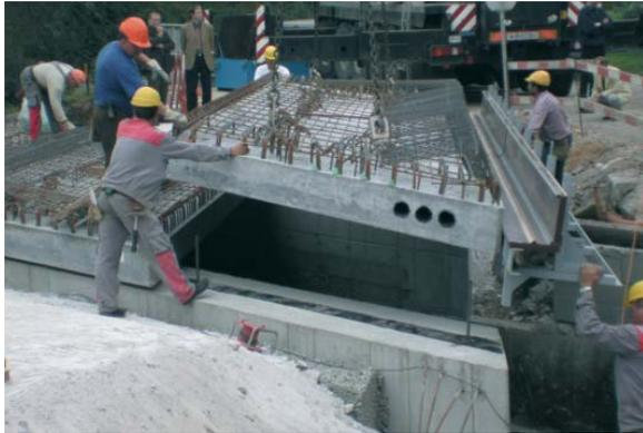
Abb. 3: Versetzen eines Fertigteils
