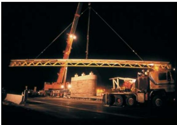
leichte und einfach zu handhabende Fertigteile. Je Tragwerk wurden drei Träger im Ganzen zur Baustelle transportiert und eingehoben. Mit der Ergänzung durch Endquerträger und Fahrbahnplatte aus Ortbeton entstanden wieder monolithische Tragwerke. Durch die Ersparnis von Schalung und Rüstung über der Autobahn war größte Wirtschaftlichkeit garantiert. Ihre Robustheit gegen (unbeabsichtigtes) Anfahren durch Fahrzeuge haben die Konstruktionen inzwischen bewiesen.
