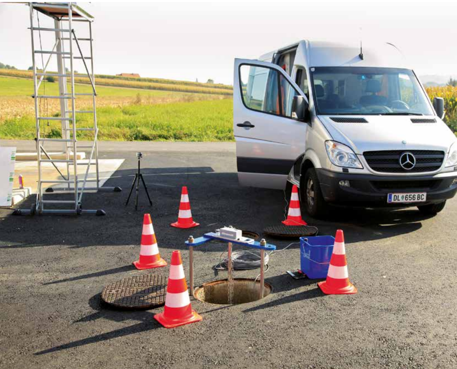
Behälterprüfung (hier Ölabscheideranlage) gemäß Pkt.: 6.5.5
