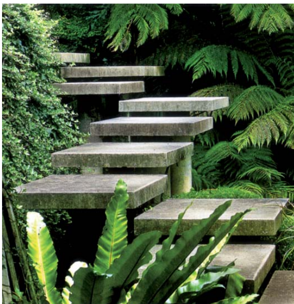
Bild 5: Betonsteine als Freiraumstiegen, Copyright o. N.
