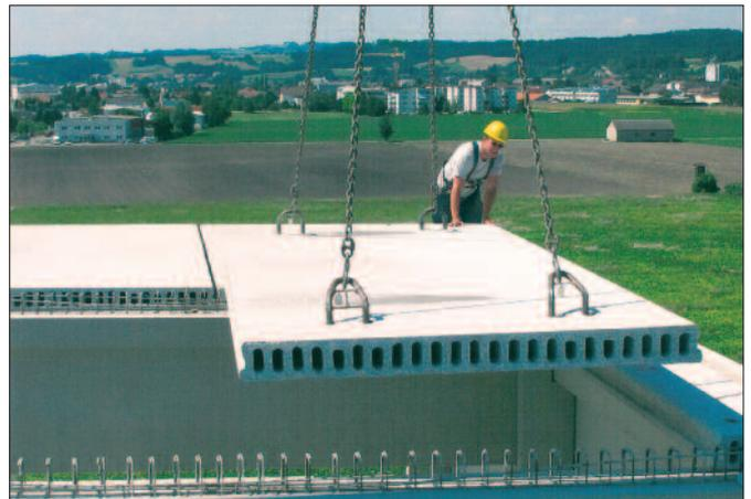
Bild 2: Versetzen von Hohldielen mit Versetzhaken
