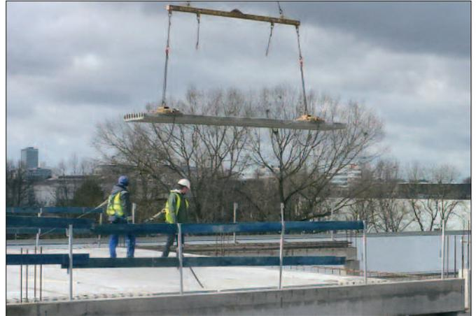
Bild 1: Versetzen von Spannbeton-Hohldielen mit Hebezangen
