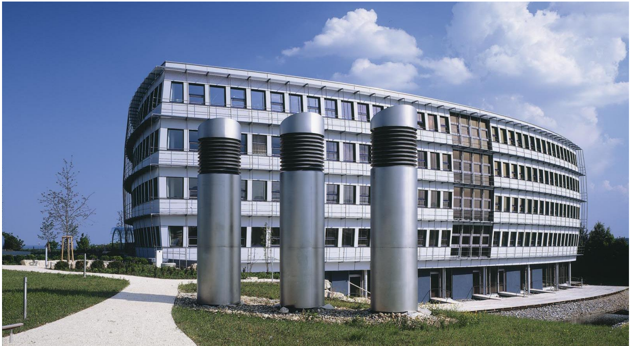
Energion Ulm: das weltweit größte Bürogebäude im Passivhausstandard nutzt Bauteilaktivierung. Bildnachweis: Energion.
