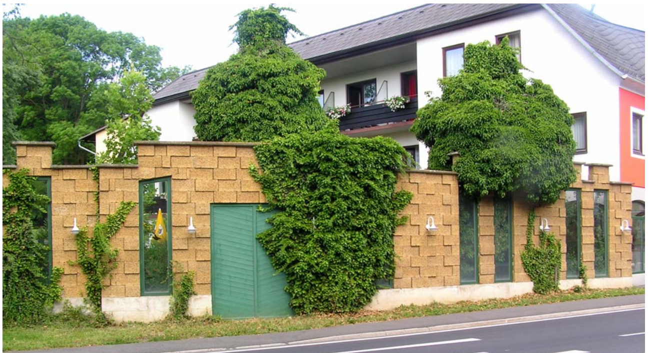
Lärmschutzwand als Einfriedung (Foto DURISOL)
