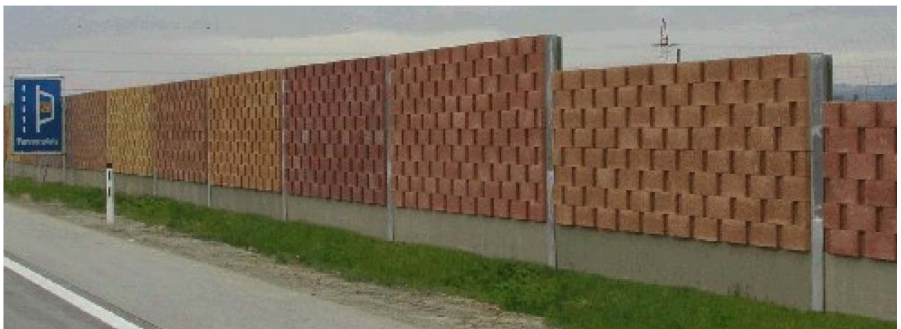
Lärmschutzwand aus Holzspan-Mantelsteinen an der A1-Westautobahn bei HAAG (Foto DURISOL)
