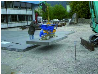
Verlegung mit Vakuumsaugern
