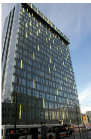
Energie AG Power Tower, Linz Bürohaus mit Passivhaus – charakter. Die im Sommer beim Kühlbetrieb anfallende Wärme wird ins Erdreich gepumpt und im Winter zum Heizen genutzt.
