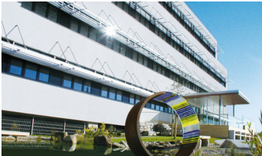
Bürogebäude „amsec“, Oberösterreich, Hagendorf setzt auf ein ausgeklügeltes Konzept mit Betonfertigteilen.
