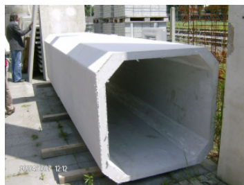
Wildbrücke, Betonfertigteil aus UHPC. Bild: Strabag
