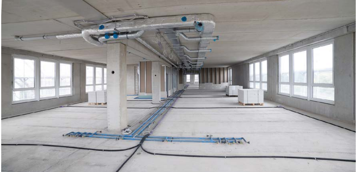
Spannbetondecken bieten mehr Flexibilität bei gleichzeitiger Reduzierung der Geschosshöhen.
