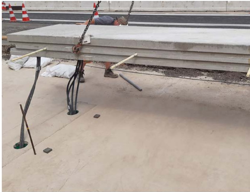
Verlegung eines Fertigteilmoduls.
