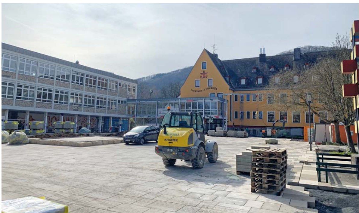
Das Recyclingpflaster wurde für die Schule in Lahnstein objektbezogen in der Farbstellung sandgrau mit fein gestrahlter Oberfläche gefertigt.
