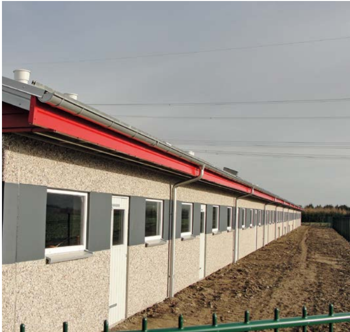
Schweinestall mit wärmegeprägten Wandfertigteilen.
