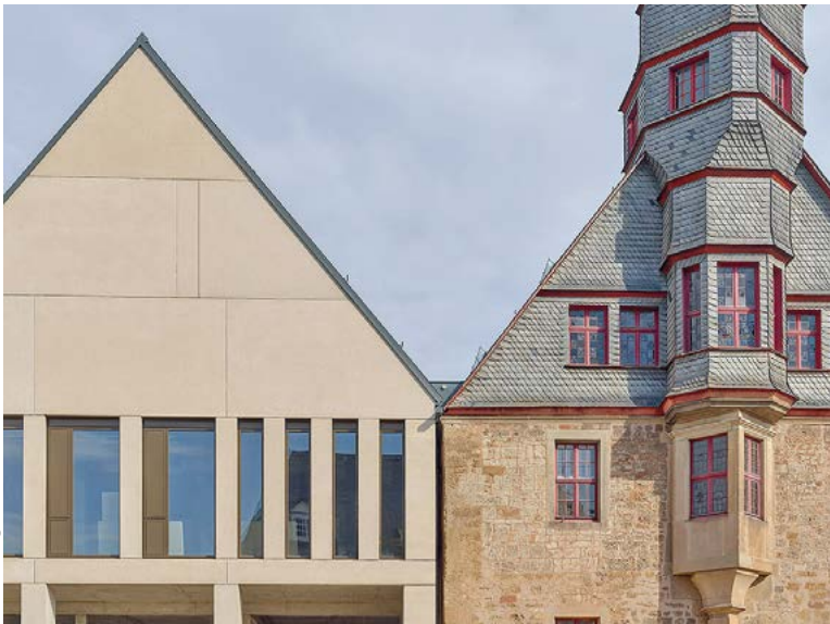
Bild 1: Fassadelemente aus Recyclingbeton unter Verwendung des vor Ort rückgebauten Gebäudes als Beton- und Ziegelrezyklat, HERING Bau.
