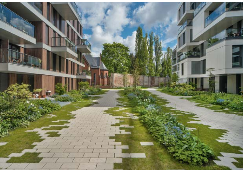
Entsiegelung in einem Wohngebiet.
