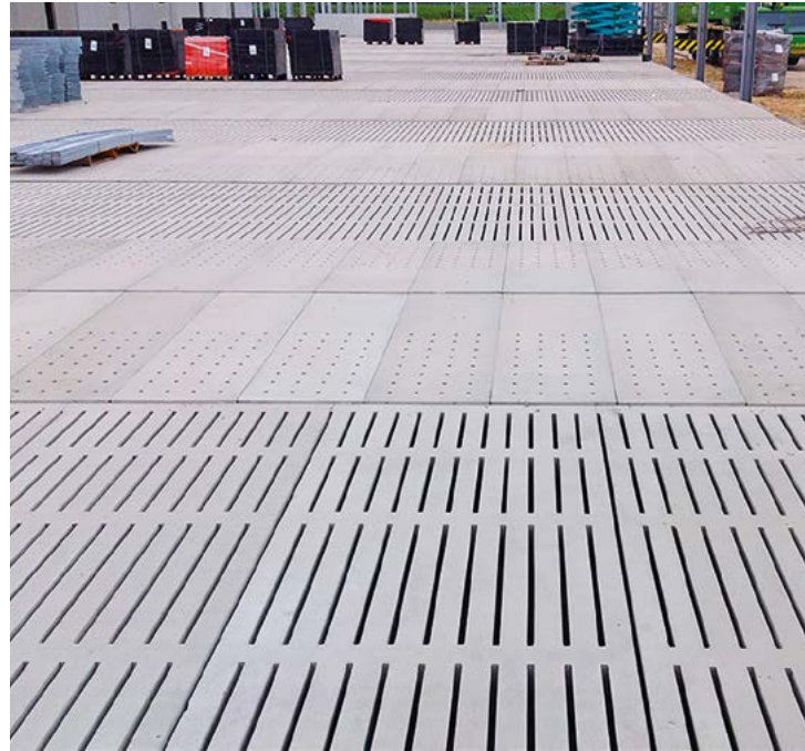
Spaltenböden mit unterschiedlichen Öffnungsanteilen.
